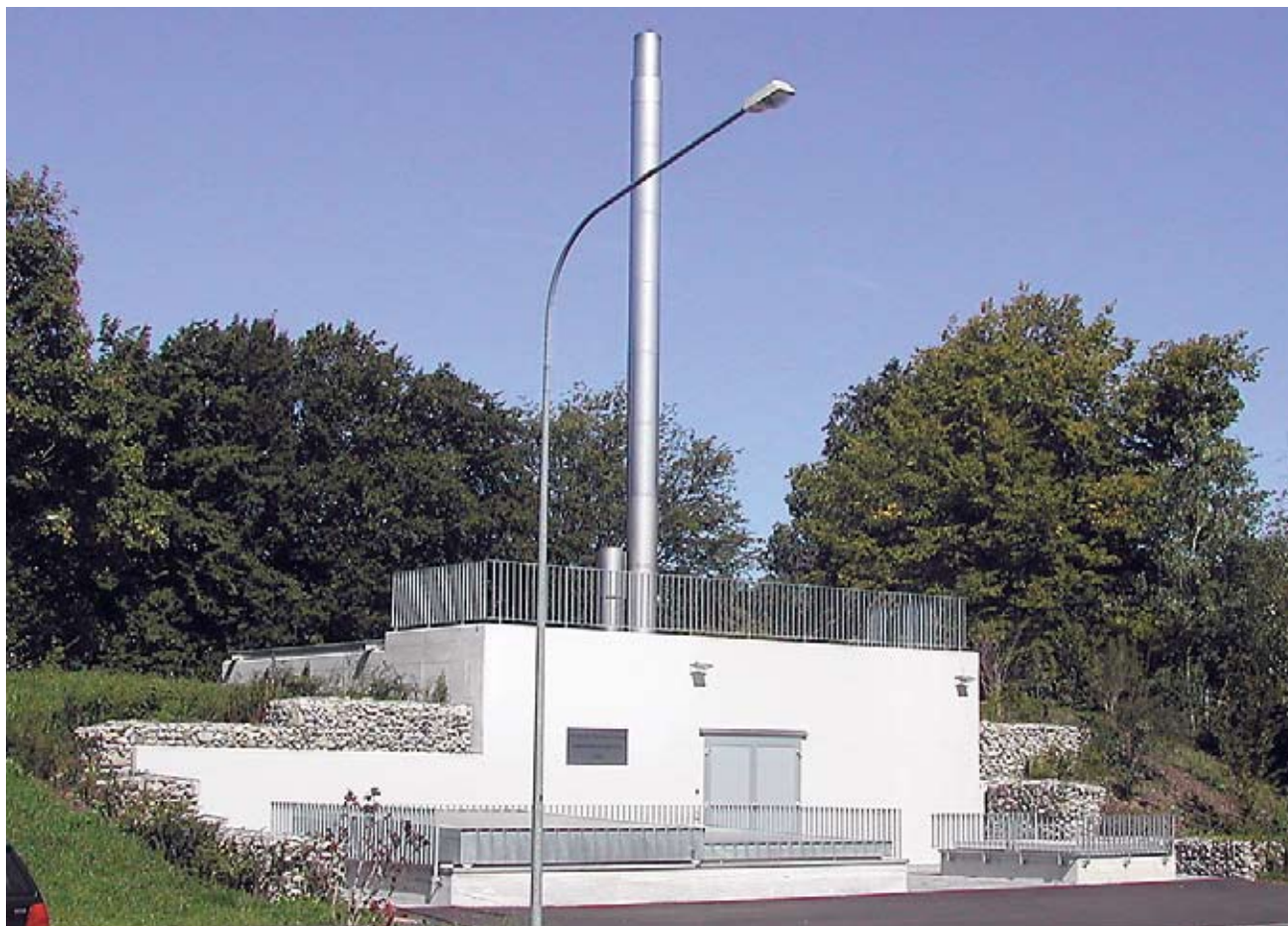
Die Heizzentrale: Der Hauptteil ist (für eine optimale Integrierung in die Umgebung) unterirdisch angelegt. Bild: TB Amriswil
